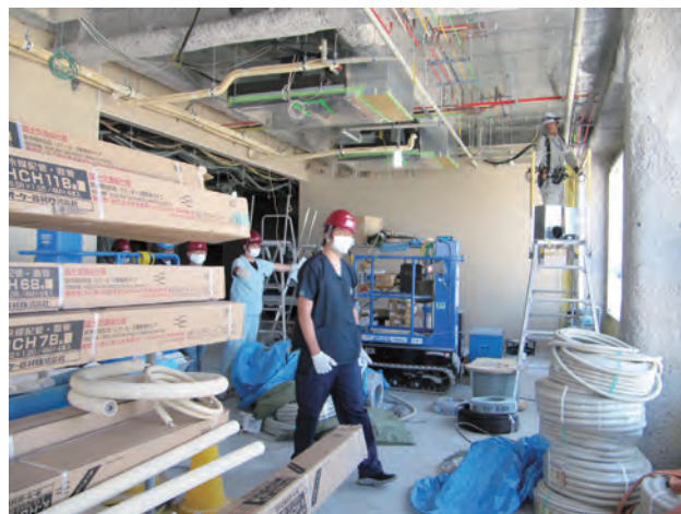
小児救命救急センター工事中
